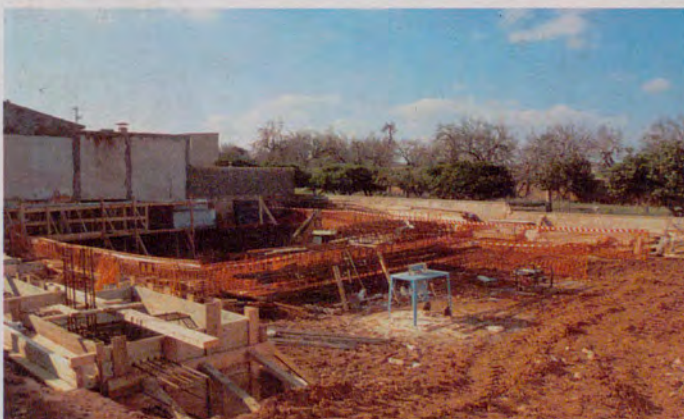
Les obres de la nova unitat sanitària d'Algaida continuen a plena marxa. El president del Govern Balear, Francesc Antich, la consellera de Salut, Aina Salom, i el batle d'Algaida, Jaume Jaume, posaren la primera pedra durant la passada fira del 10 d'octubre.
