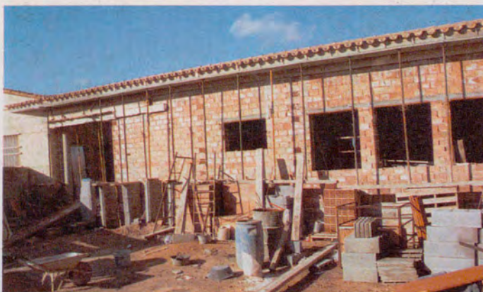
L'estructura externa de l'escoleta municipal està bastant avançada, i pràcticament es pot veure ja com quedarà el nou edifici annex a l'escola. L'Ajuntament espera que aquest any es finalitzin les obres.
